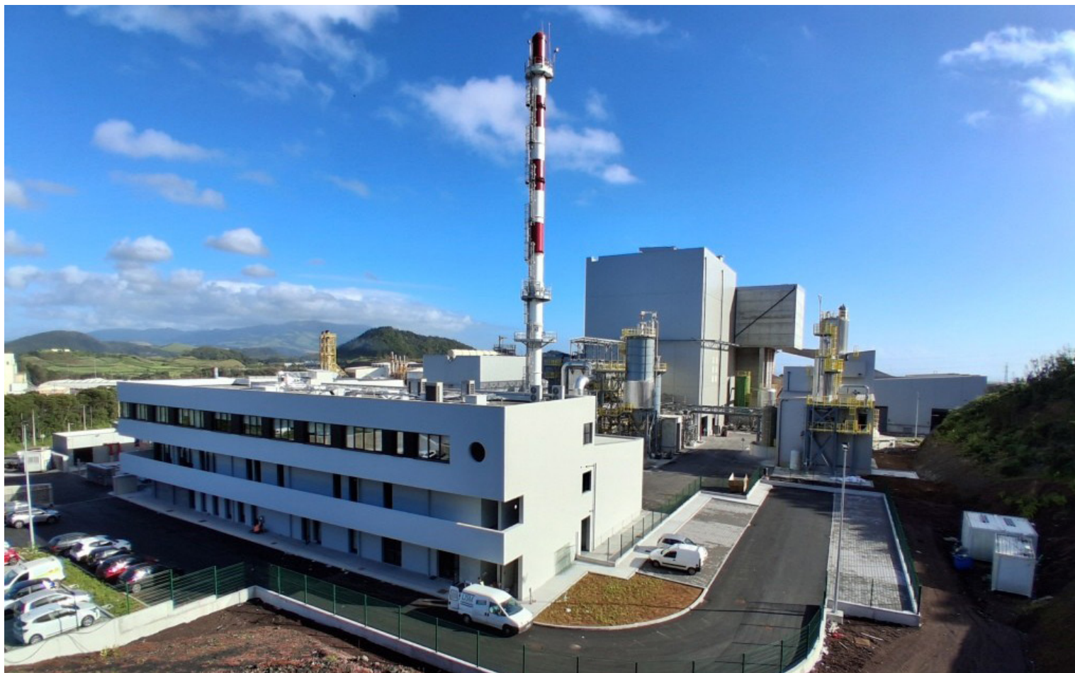
Edifício de apoio e Central de Valorização Energética
